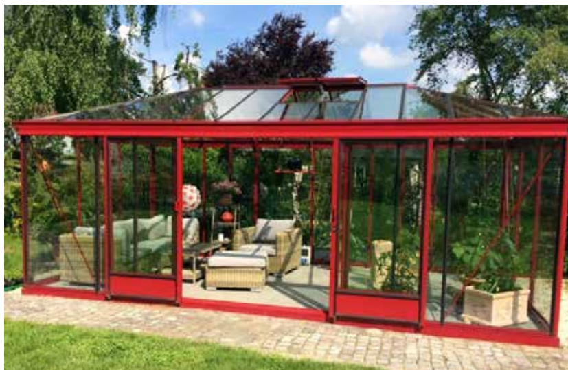
Dach 16 mm Isolierglas VSG Seitenwände 14 mm Isolierglas
