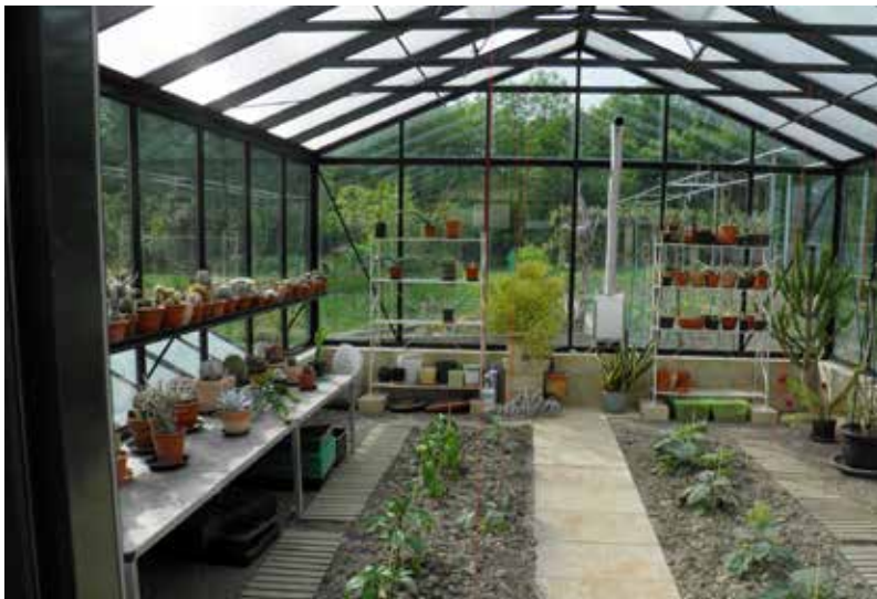
Dach 16 mm Stegdreifachplatte Seitenwände 14 mm Isolierglas
